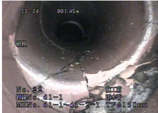
写真 1 施工前状況 J3
