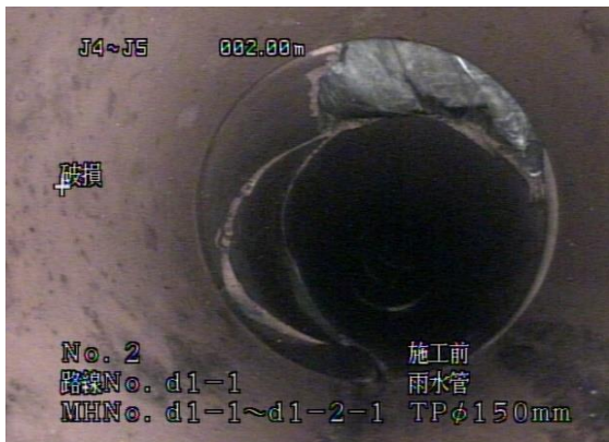
写真 3 施工前状況 J4
