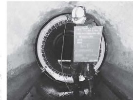
管内での施工
